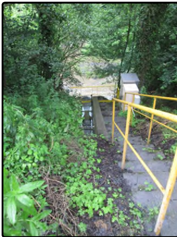
Photo du rejet des eaux d'exhaure au ruisseau du Bavay (source : KALIES)
